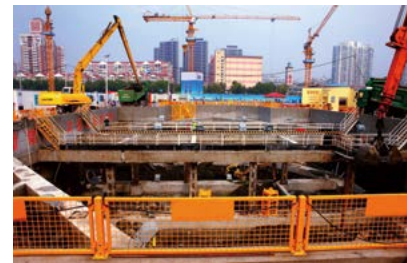
虹口区丹东排水系统施工现场
