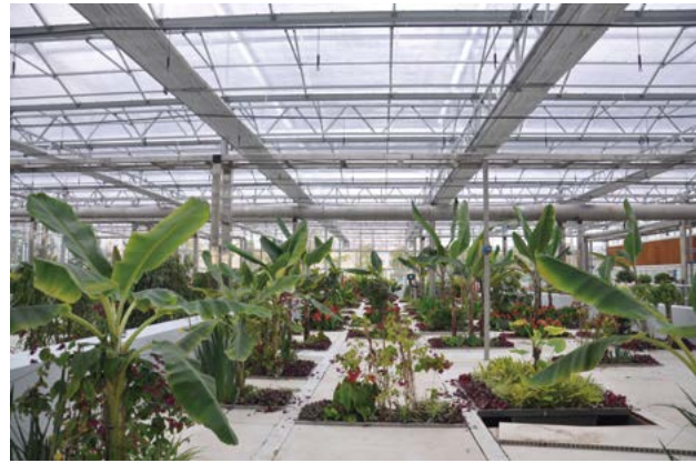
吴淞污水处理厂 FCR 生物池
