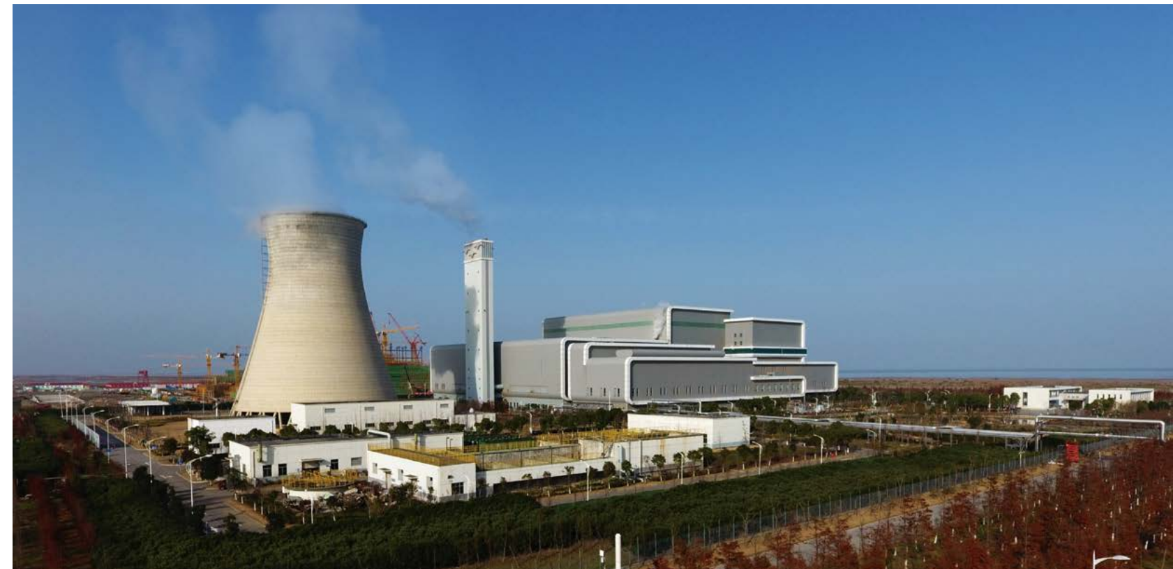
老港再生能源利用中心远视图
