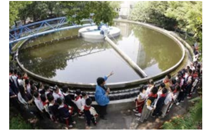
东区污水处理厂开放参观
