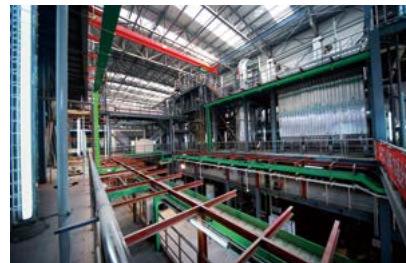
石洞口污泥完善工程车间
