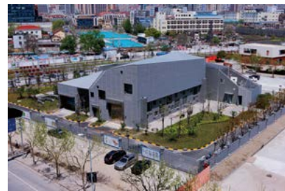
新宛平排水系统工程改造完成全景图
